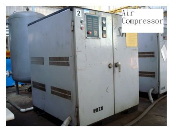
圖一 螺旋式空氣壓縮機
