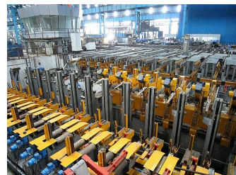
西門子鋼條軋鋼設備
