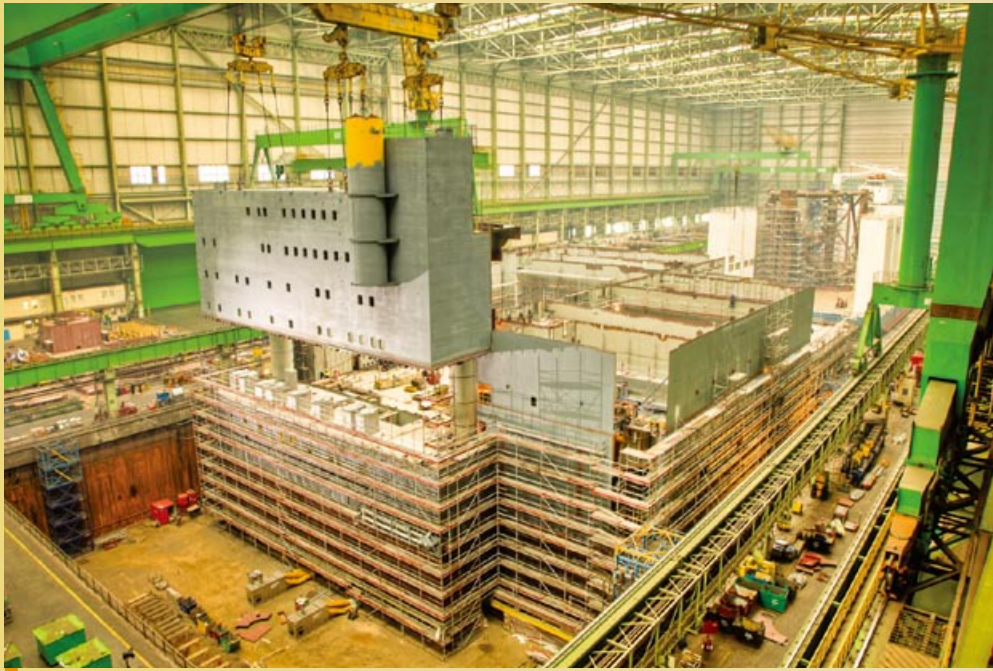
德國北海港口羅斯托克 (Rostock) 附近的造船廠中，西門子公司正在建造一座巨大的平台，把設備安裝在上面，以管理遠處岸外風力發電廠產生的電力。
