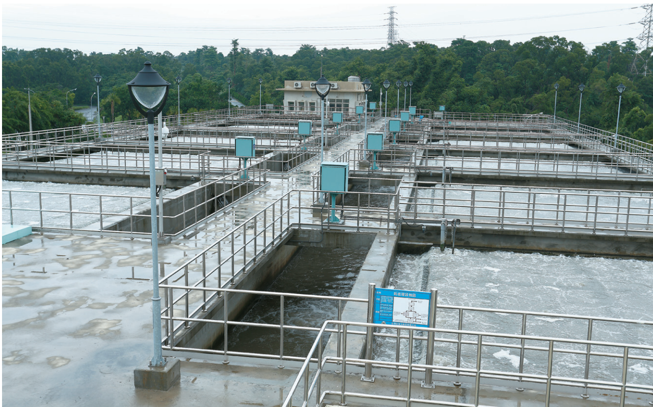
東港溪運用 BioNET 技術可去除氮氫及有機質，經處理後之水質可符合飲用水水源水質標準，再經過後端處理後即是符合標準的自來水。
