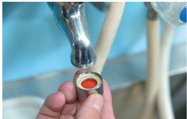
在水龍頭出水口連接起波器，能讓水流呈泡沫狀出水，有效節水。
