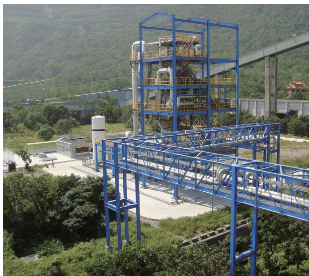
台泥與工研院合作全球規模最大的鈣迴路捕獲二氧化碳先導型試驗廠，奠定了商業化發展的里程碑。
