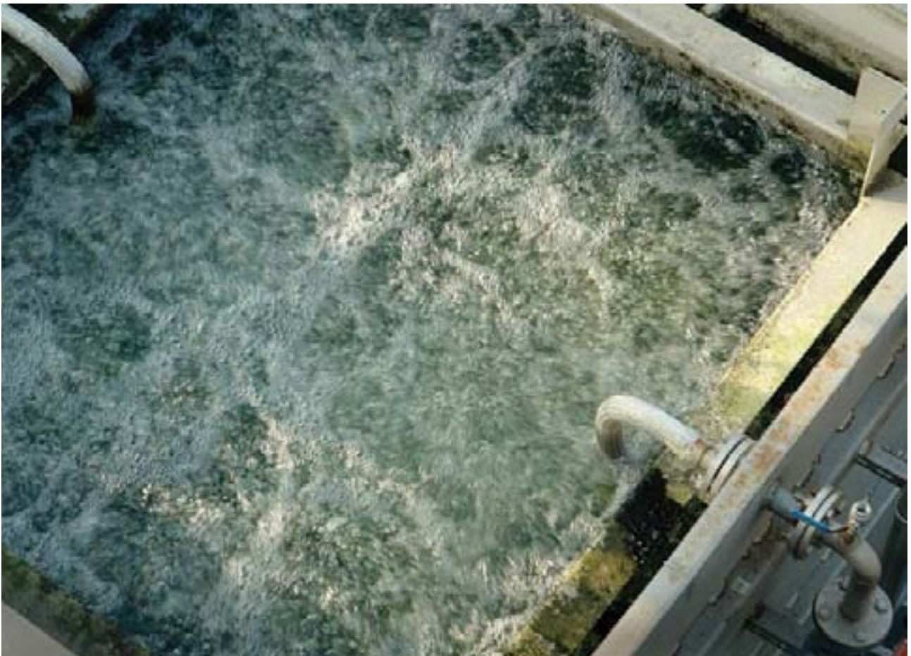
康那香的污水處理系統，是和工研院能環所合作，利用薄膜生物反應器及生物擔體，分解水中的有機物。
