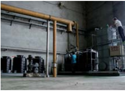
新世代生活污水處理技術改善了好氧生物處理系統需要龐大土地面積、耗時及污泥量大等缺點。
