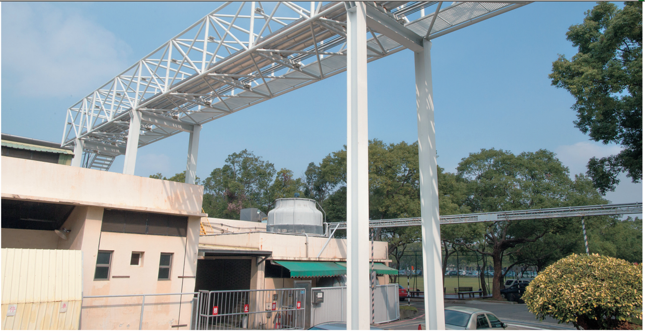
工研院建構整體區域能源中心，將所有空調、熱泵、空壓系統等進行整合，達到有效節能的目標。
