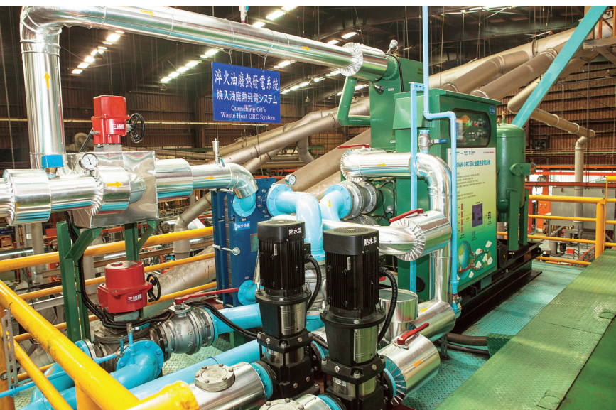
東培工業導入工研院創新研發的「有機朗肯循環（Organic Rankine Cycle; ORC）低溫廢熱發電機組」，成功將廢熱回收再利用。
