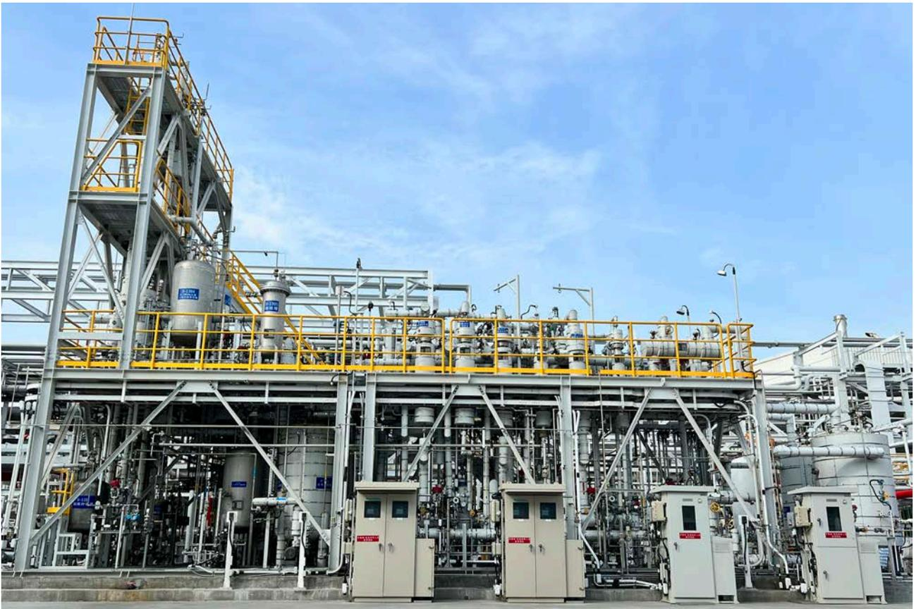
全臺第一套「二氧化碳捕捉及再利用」前導示範場域，促成從「二氧化碳捕獲」、「氫氣純化」，到「轉化再利用」三大系統的循環經濟模式。
