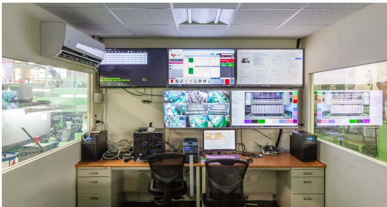
大亞電纜與工研院合作建置的「雲端戰情中心系統」，能自動蒐集廠房內各機台數據，並回傳至這間雲端戰情室中。
