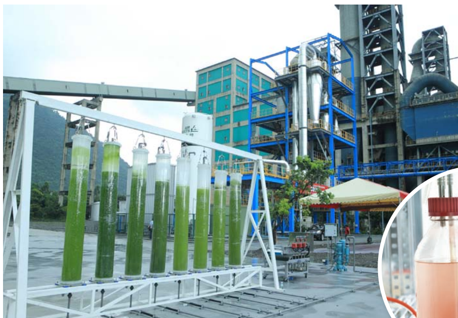
工研院與台泥合作建置全球規模最大的鈣迴路捕獲二氧化碳試驗廠，將捕捉到的二氧化碳用於養殖雨生紅球藻，做到工廠零排放。
