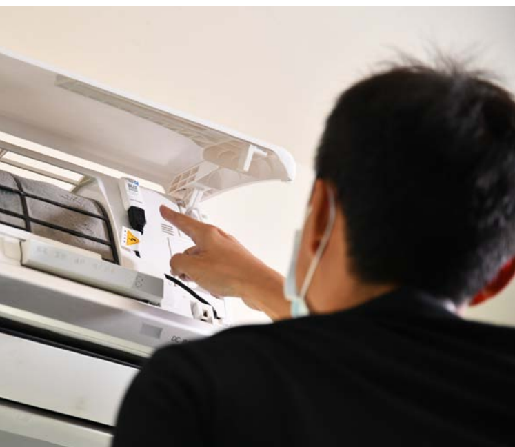
每台電力設備透過工研院研發的通訊模組，校方便能即時掌握每間教室空調設備的用電資訊。
