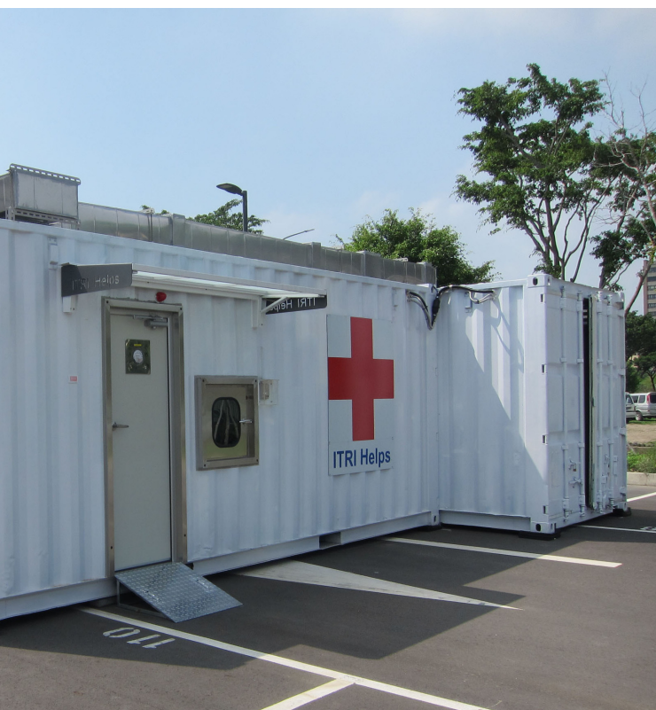
奇美醫院與工研院共同打造貨櫃組合式微負壓超高通量新冠病毒檢測實驗室，共同守護醫護與國人健康。
