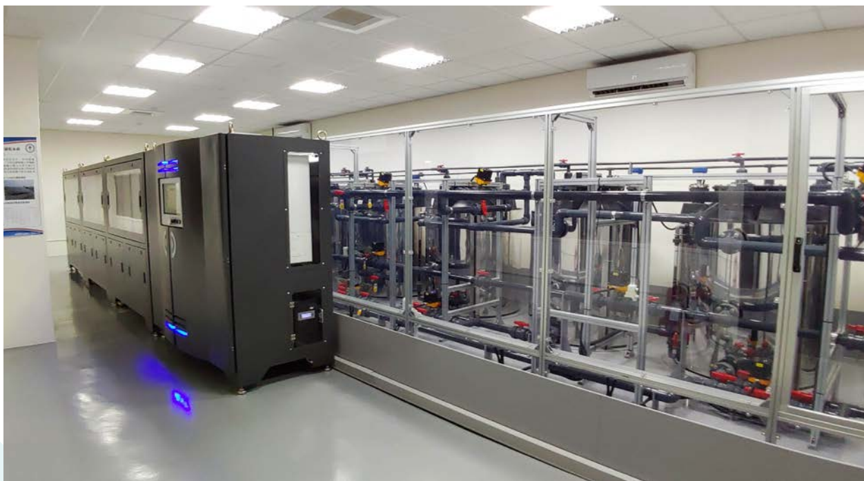
由於能量是儲存在液體裡，桶槽愈大，能提供的能量就愈多，根據不同應用情境，只要增加桶槽與電解液，儲存的能量與時間就能更多、更久。
