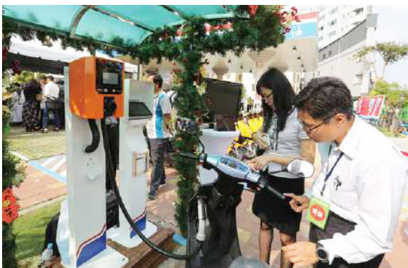
工研院和中油攜手打造首座多元電力供應及儲能系統的智慧加油站「臺南前鋒路示範站」。(中油提供)
